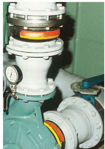
STENFLEX® Typ AR-1 an Pumpen
